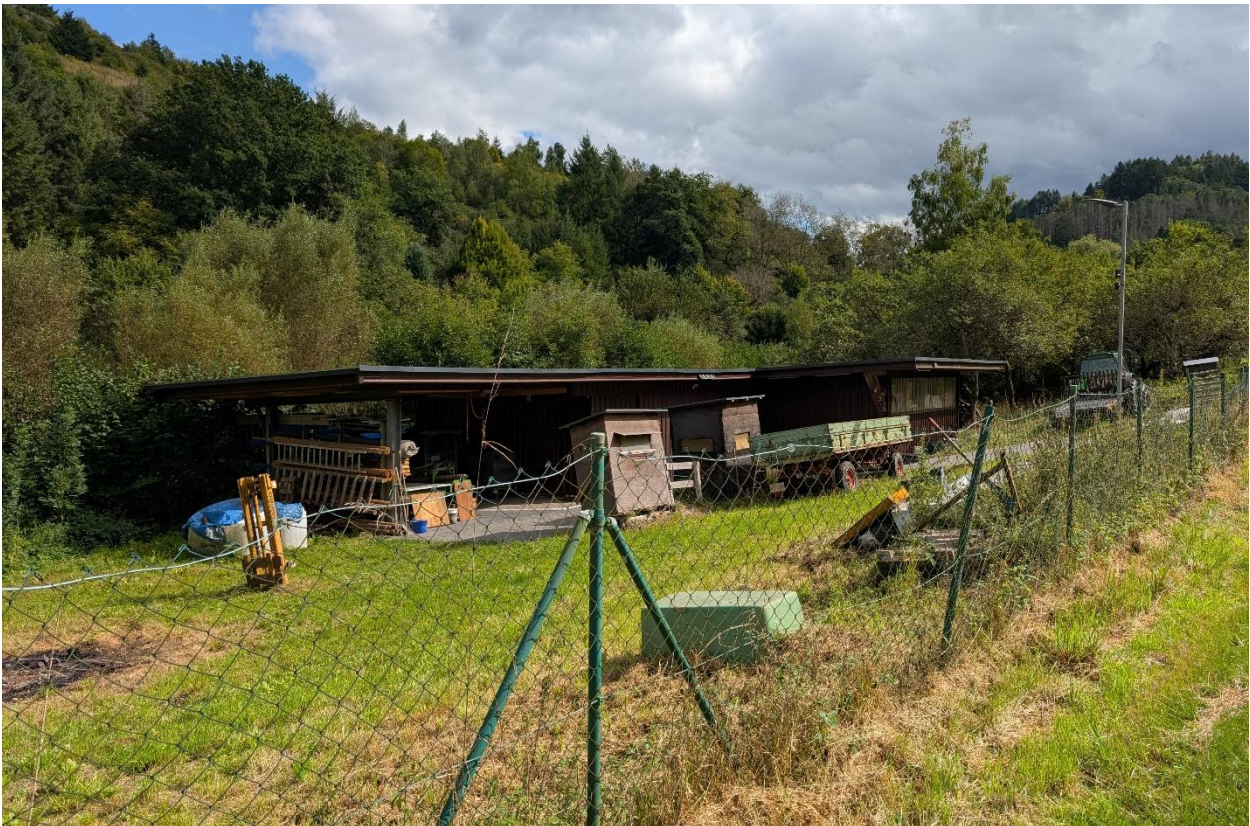
Abb. 6: Blick von der Gartenstraße auf das Plangebiet mit Geräteschuppen im Mittelpunkt (Aufnahme: P & P GmbH).
